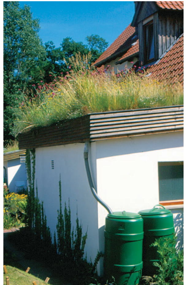
Vorbildlich: Das Dach des Anbaus ist begrünt, und überschüssiges Wasser vom Dach wird in Regentonnen aufgefangen – da geht kein Tröpfchen verloren Foto: Niemeyer-Lüllwitz
